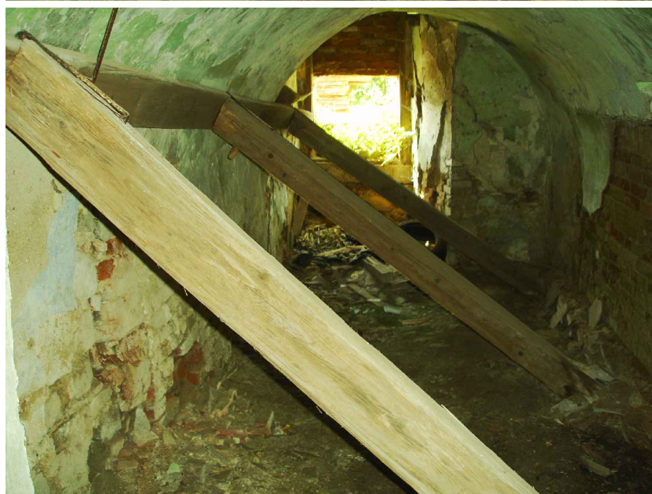
Místnost 1.15 stávající statické zajištění stěny
